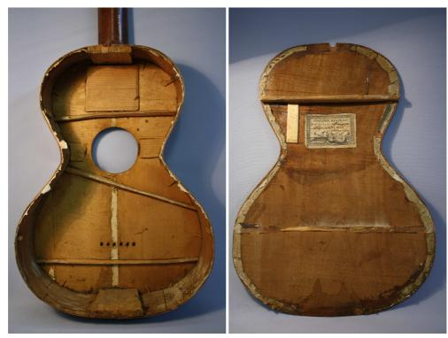
Si procede quindi alla rimozione delle catene dal fondo ed alla rimozione del rinforzo posticcio applicato nel corso del precedente restauro, che sarà sostituito da una serie di diamantini, ed alla pulizia della sporcizia e delle tracce di colla presenti sul fondo, rimuovendo accuratamente i residui di carta dal bordo per facilitare la perfetta chiusura al momento dell'incollaggio. Dopo questa operazione il fondo viene collocato tra pesi per evitare torsioni o deformazioni.
